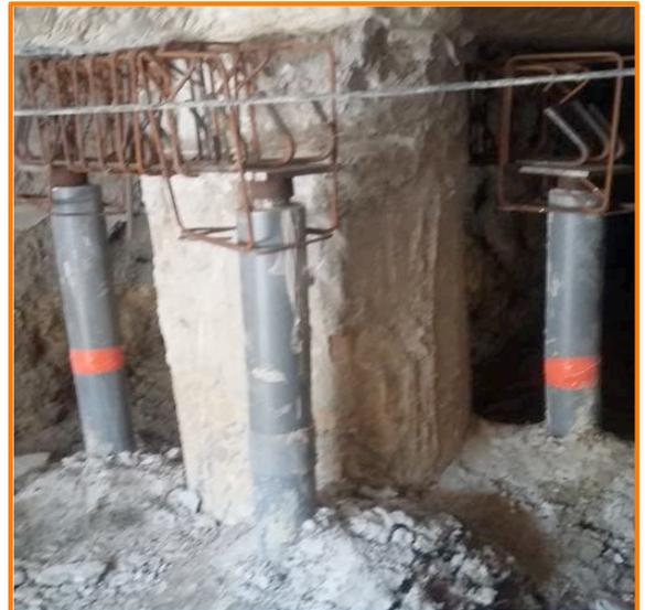
Après les travaux de passivation des ferrailles de la dalle rendus nécessaires après constat des malfaçons mises à jour lors des terrassements (Coût total à la charge de la collectivité pour la « modique » somme de 58 295,40 € supplémentaires !!!), les travaux de renforcement des fondations touchent à leur fin. Il reste maintenant à relier les micropieux de part et d'autre des pieux d'origine par un ferrailage et procéder au coulage d'un béton.
